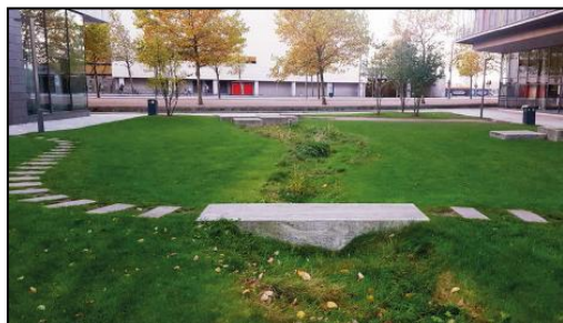
Figur 14. Exempel på svackdike.
